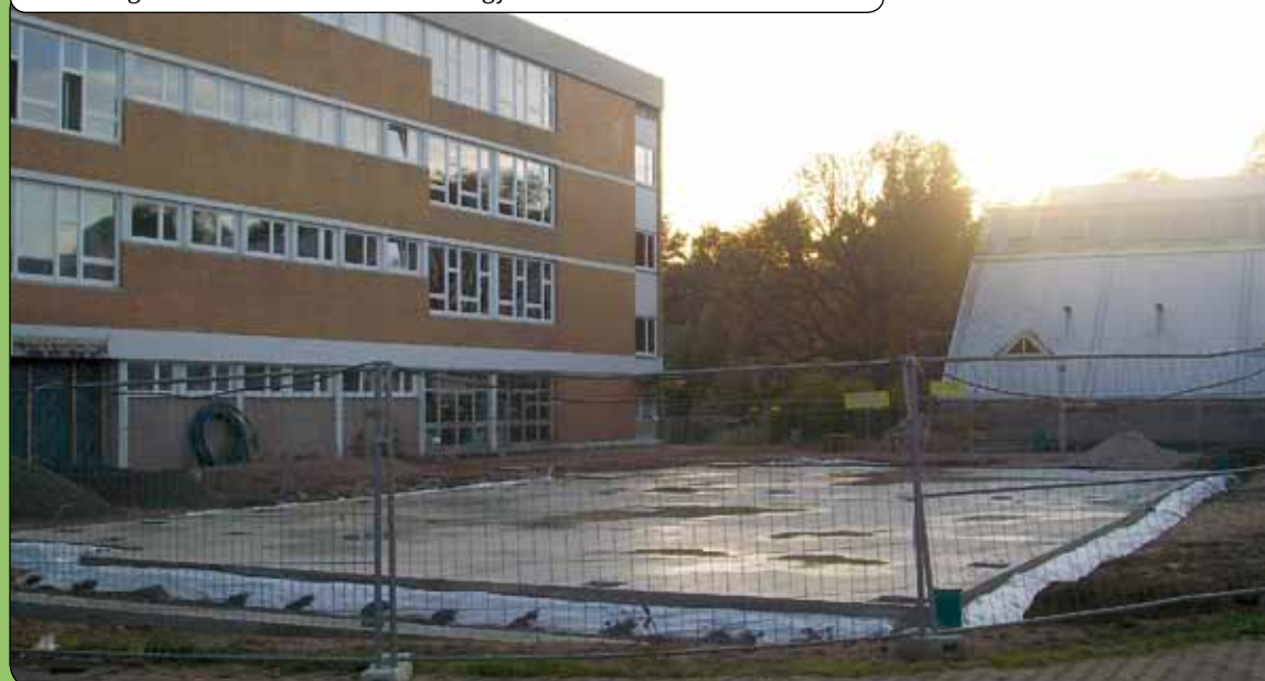
Bald fertig: die neue Mensa des Wilhelmsgymnasiums. Foto: Klaus Amler
